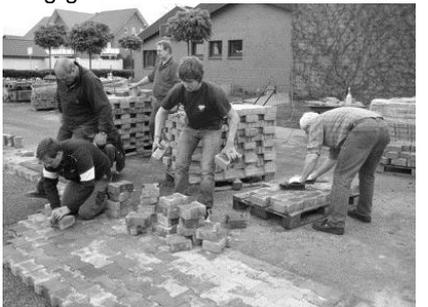
ausgeköffert und Kabel und Rohre verlegt, sowie Schotter verteilt und dann viel Verbundsteinpflaster gelegt werden. Viele Kameraden halfen, bis im Herbst die Anlage fertig gestellt werden konnte.
